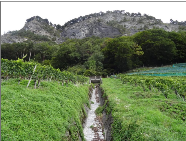
Blick hangaufwärts auf befestigte Rufensohle und Mauer, Foto R+K
