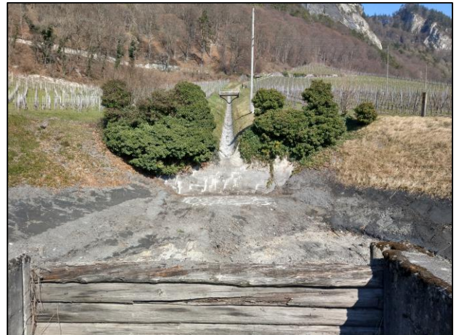
Blick auf Rufe mit ausgebaggertem Auffangbecken, Foto R.Pahud
